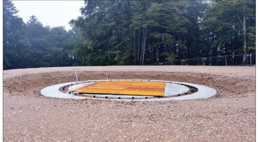
Parc de Sainte-Croix : le permis de raccordement a été délivré. Les six éoliennes seront érigées dès avril 2023.
